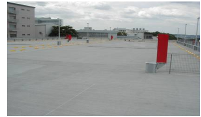
駐車場スラブ面強化(防塵)
