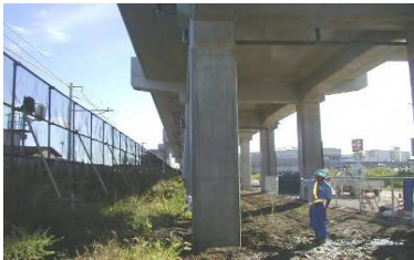
橋脚中性化防止
