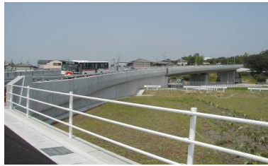
壁高欄劣化防止
