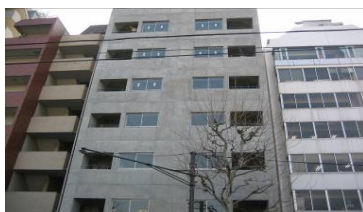
マンション外壁疎水材塗布
