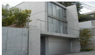
住宅外壁疎水材塗布
