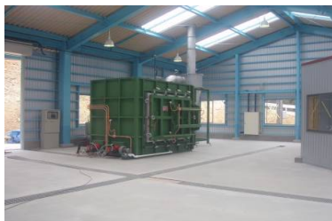
工場土間防塵
