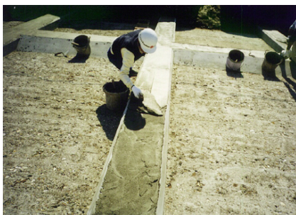
欠落部補修状況
