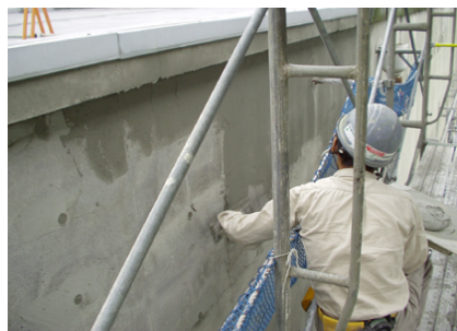
薄付け仕上げ状況
