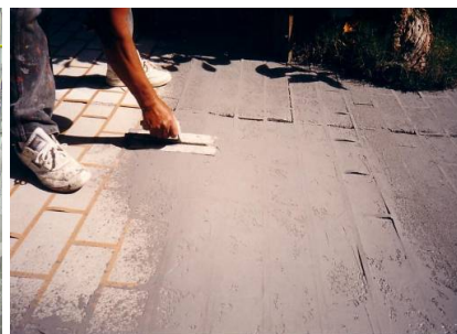
パターン仕上げ状況
