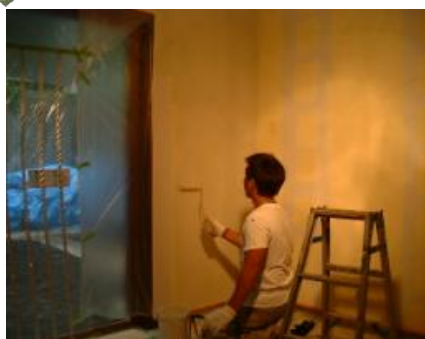
施工中(神奈川県宿泊施設)
