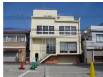
施工後(青森県住宅)
