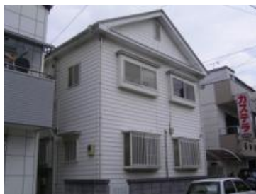
施工後(長崎県住宅)
