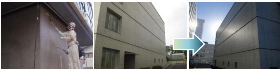
施工中(東京都研究施設)
