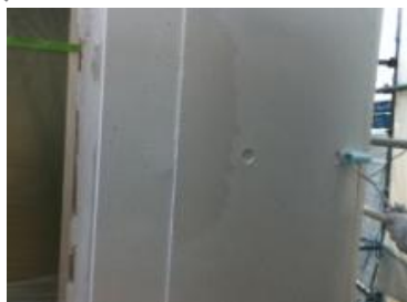
施工中(東京都マンション)
